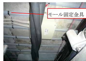
写真－２ 陽極設置状況（頂版）
