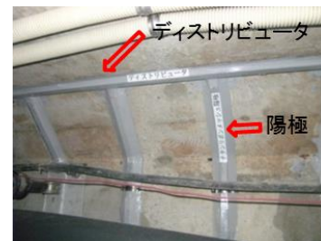
写真－１ 陽極設置状況（側壁）
