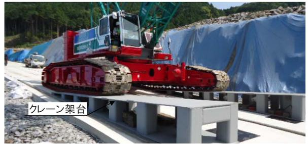
【写真-3 クレーン架台を用いた据付け状況】
