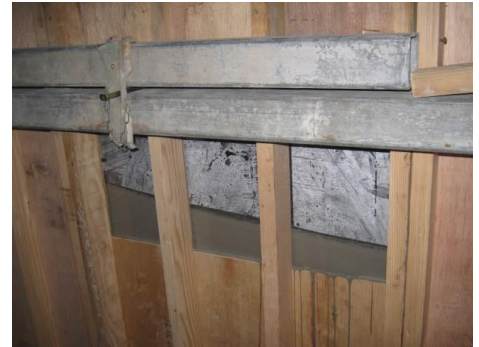
写真-1 充填確認用透明型枠
