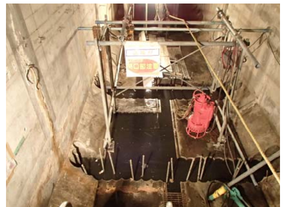
写真1：頂版削孔後の様子
