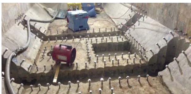
写真3：開口部鋼製蓋設置前状況
