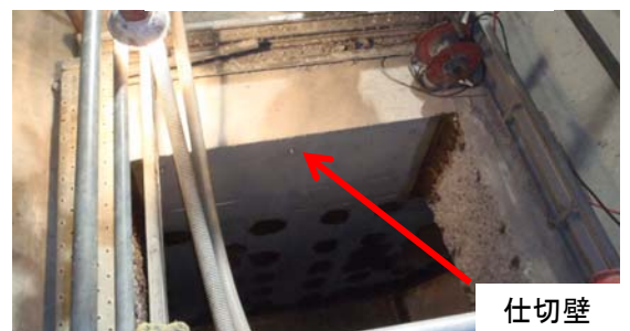
写真2：仕切壁打設完了状況
