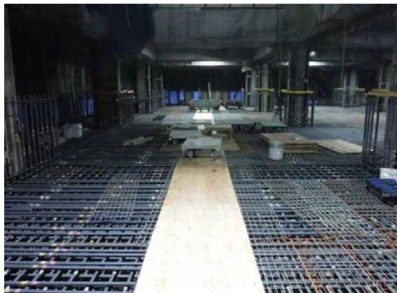
写真 2 ヘッドバーの搬入経路
