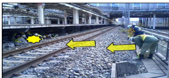
写真-2 トラフから着色水流入ホーム側流出確認
