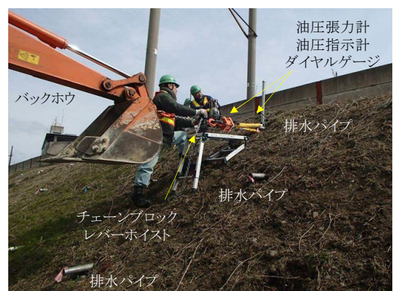
図3 引抜き試験の状況
