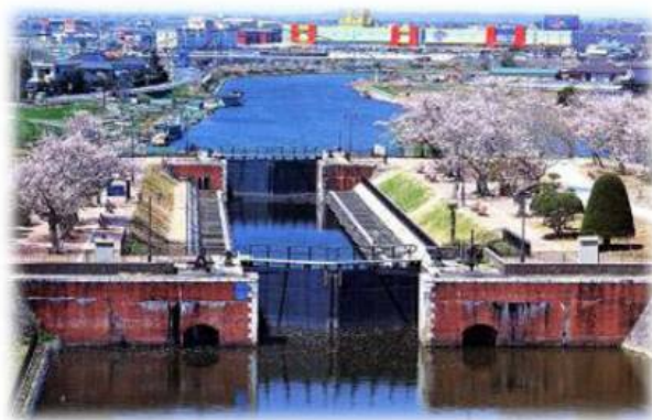
写真-1 横利根閘門全景
