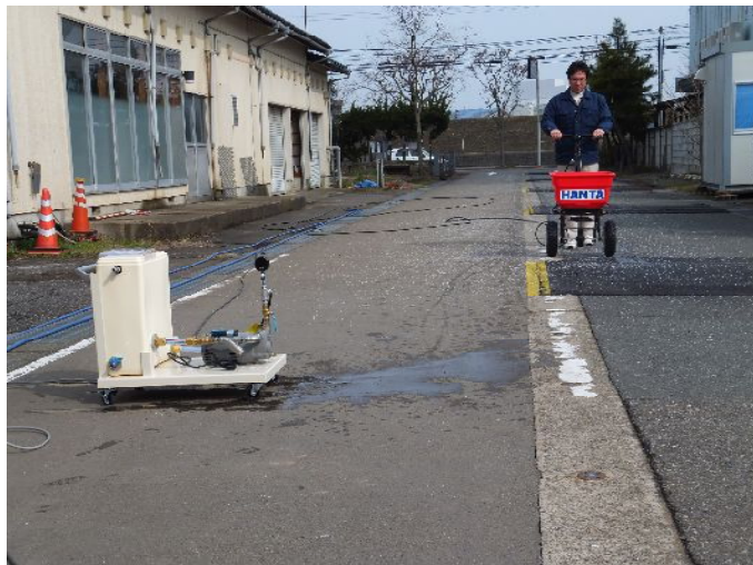
写真-1 散布試験状況
