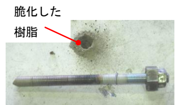
写真-4 ボルト状況 (ボルトヒーター加熱)
