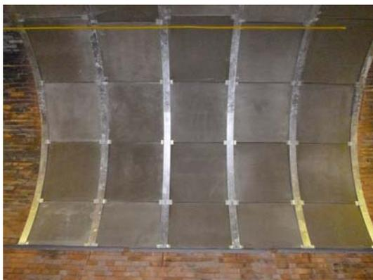
写真-5 支保工薄型パネル設置状況
