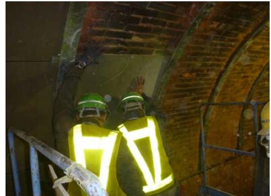
写真-4 薄型パネル設置
