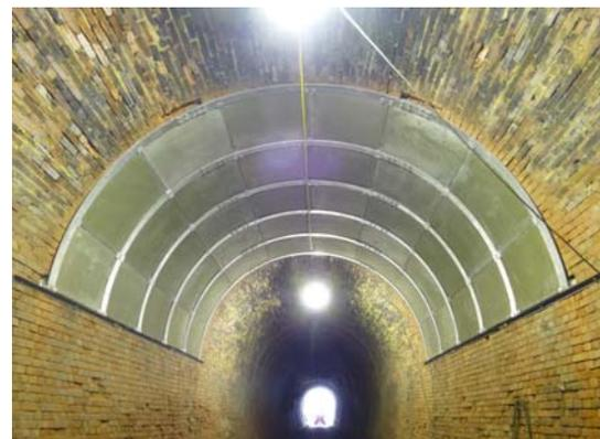
写真-6 修繕工設置完了
