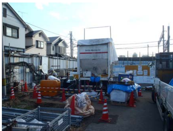
写真 4.1 作業プラント
