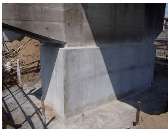
写真 5.2 吹付け完了写真
