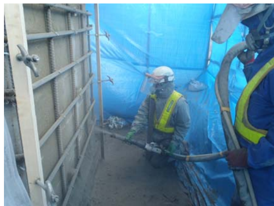
写真 5.1 吹付け状況写真
