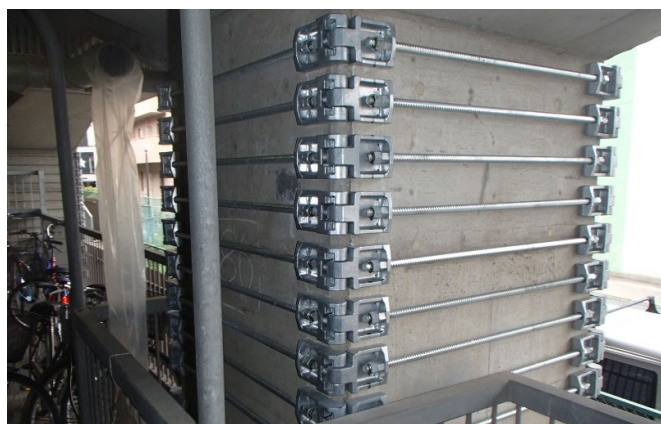
写真-1 スリムRB設置状況
