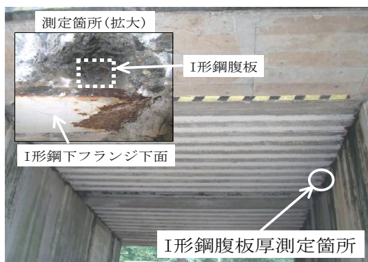
図2 I ビーム埋込桁下面及び I 形鋼腹板
