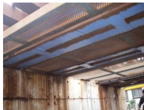
写真2 上り線桁下部
