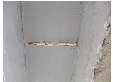
写真6 桁下面の状況
