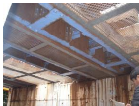
写真4 下り線桁下部
