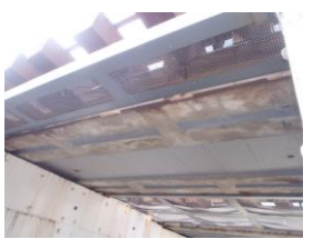
写真3 上り線桁下部(施工後)
