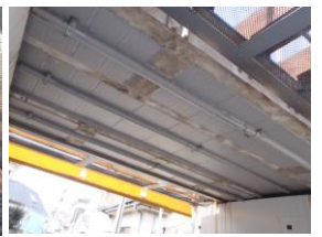
写真5 下り線桁下部(施工後)
