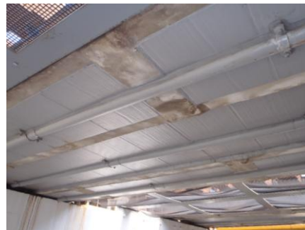
写真8 現在の下り線桁
