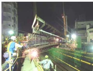
写真-1 桁架設状況
