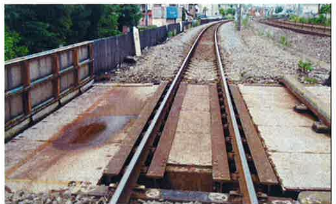
写真-1 橋りょう写真、終点を望む
