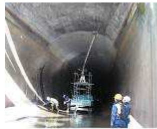
図-2 空洞レーダー調査
