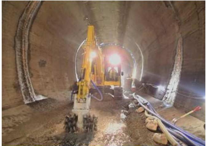
図-4 ツインヘッダーによる切削
