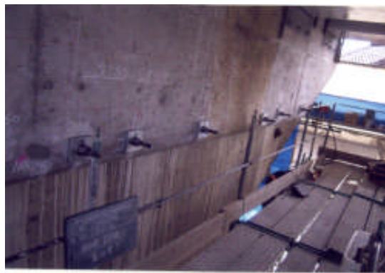
図-6 P C鋼棒締付け状況
