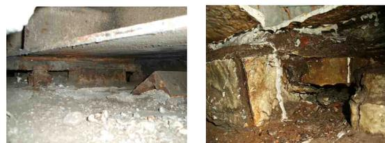
写真-2 支承の損傷状況
