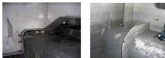
写真-1 箱桁主桁切欠き部の状況
