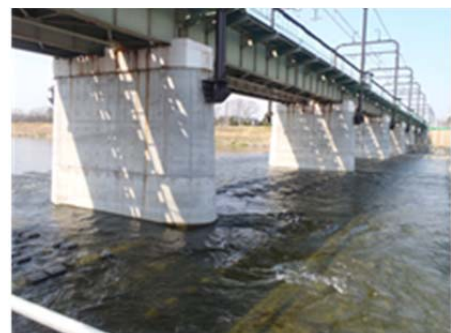
写真-2 橋梁基礎コンクリート天端(施工箇所)
