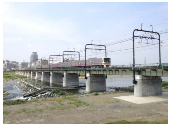
写真-1 河川を渡る橋梁
