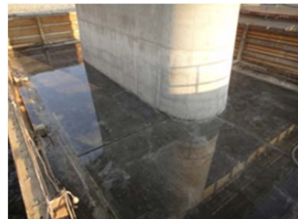
写真-4 養生完了時の状況
