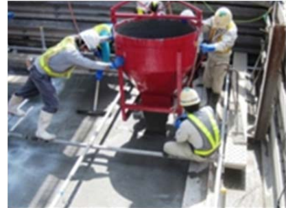
写真-3 打ち込み状況
