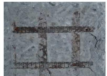
写真-2 鉄筋の腐食状況
