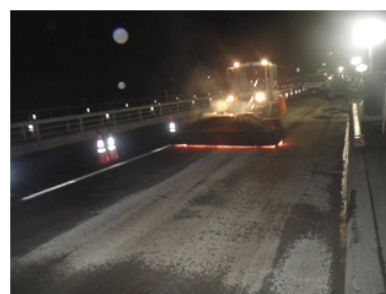
写真-1 夜間施工
