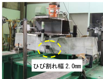
写真-5 CASE1 梁の状態
