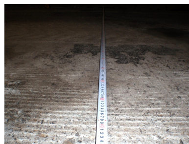
写真-2 舗装切削
