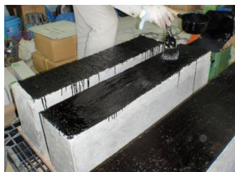
写真-3 防水材の塗付け
