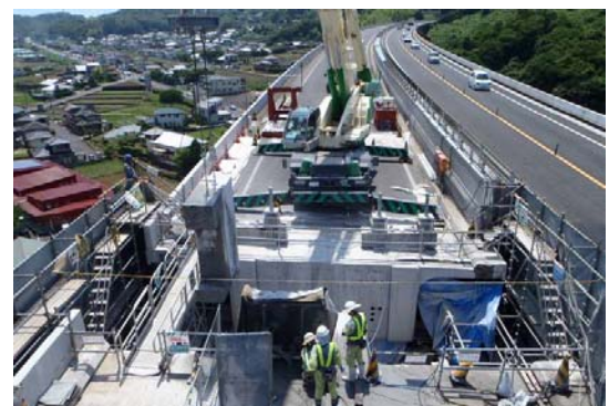
写真-2 主桁切断撤去状況
