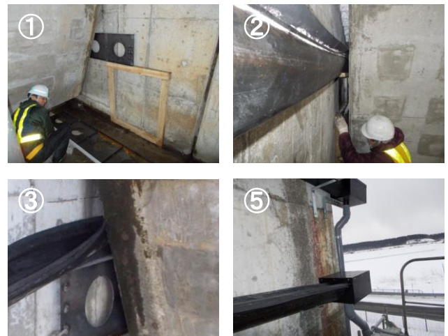
図-6 排水装置施工状況
