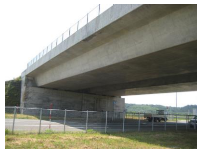
図-1 戸島ランプ橋
