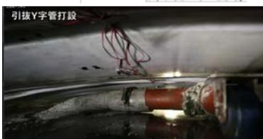
写真-3 引抜 Y 字管打設
