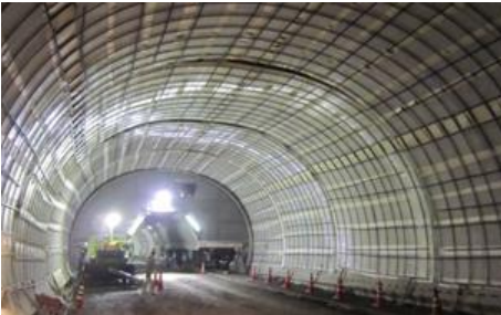
写真-1 養生状況
