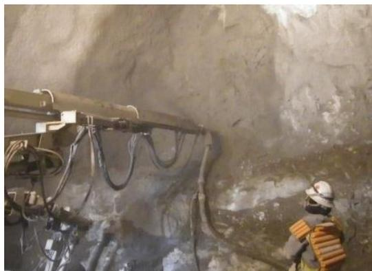
写真-2 実施工における吹付け状況
