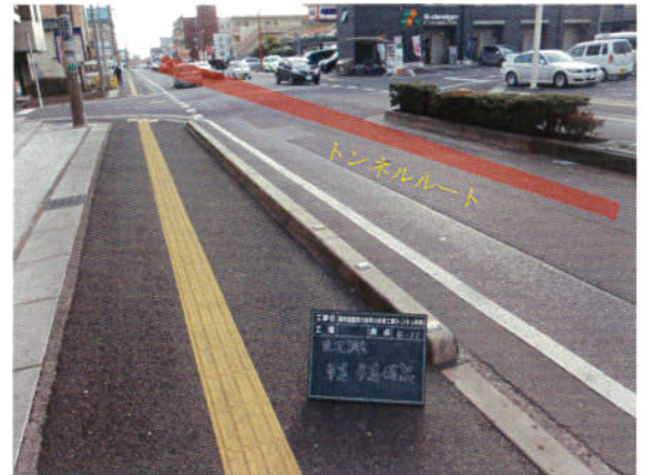
写真-1 トンネル地上部の状況
