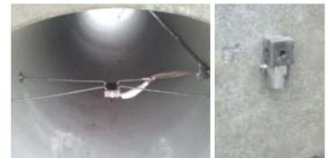
写真3 加速度センサ設置状況
