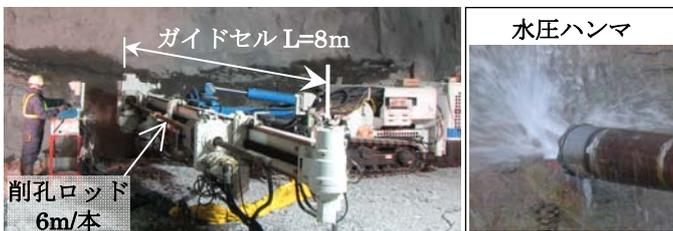
写真1 高速ノンコアボーリングシステム削孔状況
