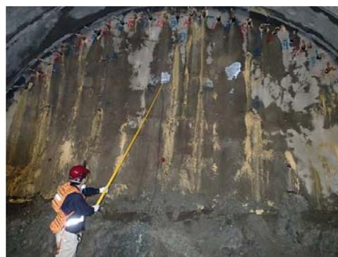
図-5 長尺ローラーを用いての塗布
