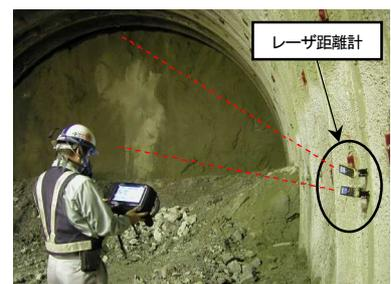
写真-1 レーザ距離計の設置
