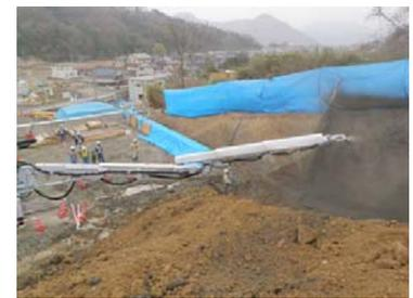
写真-6 掘削土砂越しの狭所吹付け
