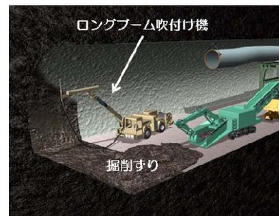
図-2 吹付けとずり出しの同時施工のイメージ
