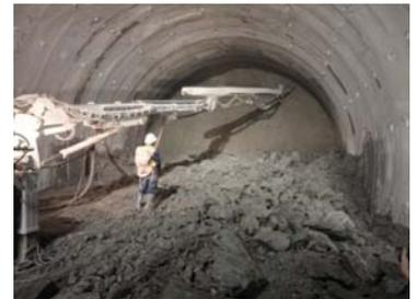
写真-3 坑内でのずり越しの吹付け
