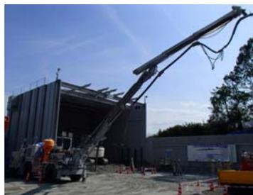
写真-5 高所の吹付け作業
