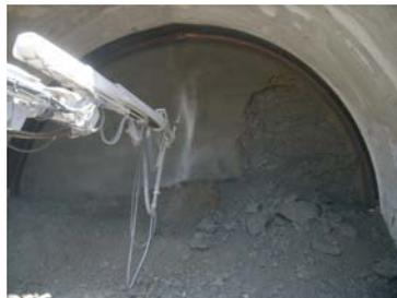
写真-1 崩壊した坑口部の切羽
