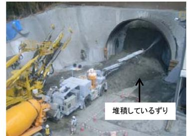
写真-2 ずり越しの吹付け作業
