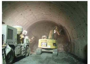
写真-4 吹付けと支保工清掃の同時作業
