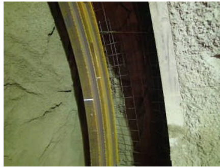
写真-1 二重支保施工状況 (E2)
