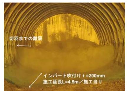
写真-1 インバート吹付け早期閉合状況
