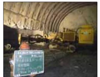
図-2 中尺水抜きボアリング(実施状況)
