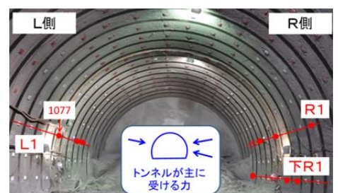
図-4 プレート設置状況
