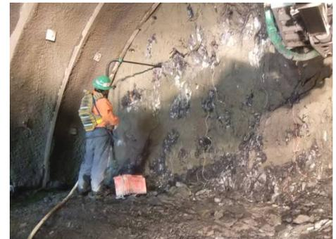
写真-2 遠隔装填による爆薬装填
