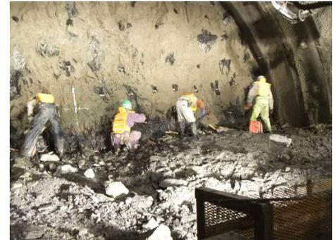
写真-1 人力による装填作業
