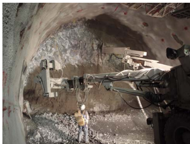
写真-1 ハイブリッド急結剤を用いた吹付け状況
