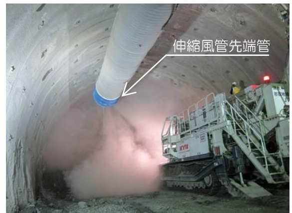
写真-3 実掘削状況
