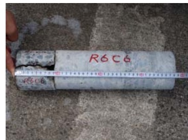
写真-1 オーバーレイ版部のひび割れ状況
