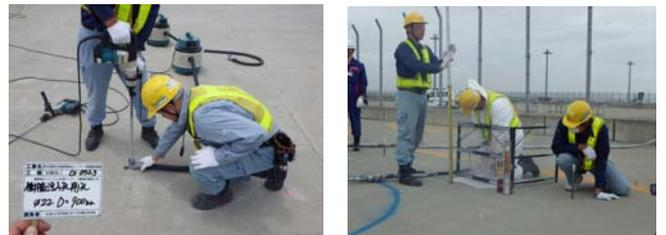
写真-2 注入孔削孔およびウレタン樹脂注入状況
