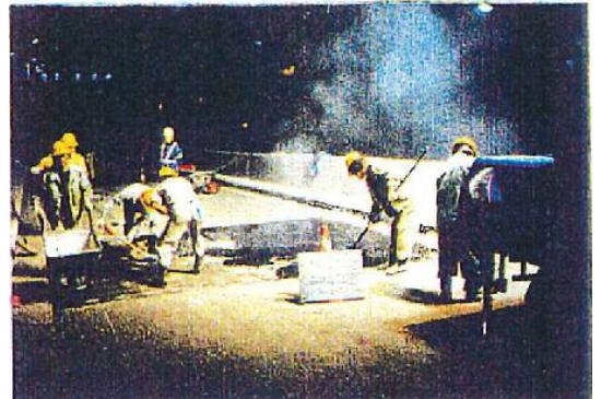
写真-2 グースアスファルト施工状況
