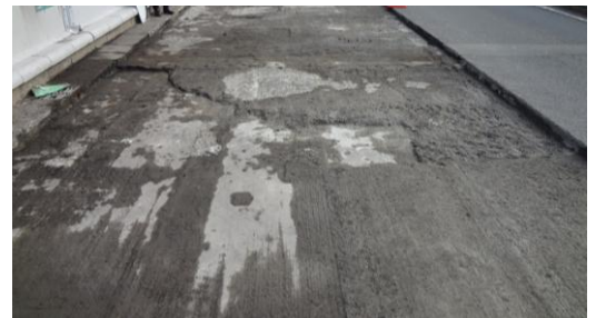
写真-3 施工基面の不陸状況
