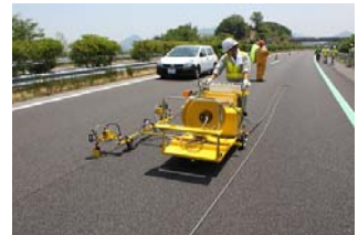
写真-4 舗装縦継目への浸透型補修材注入状況
