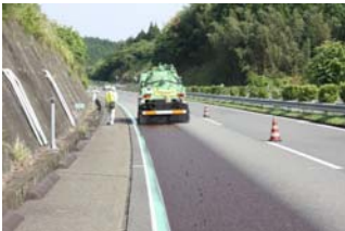
写真-1 浸透型補修材の散布状況
