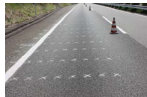
写真-5 散布直後（散布工区）
