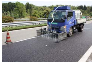
写真-2 分解材の散布状況
