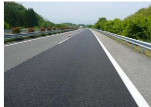
写真-3 施工完了
