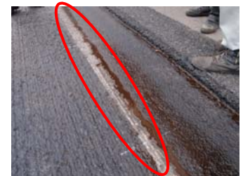
写真-1 浸透型補修材注入完了
