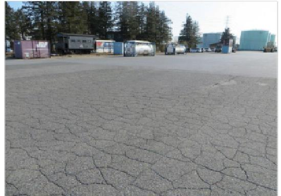
図-1 コンテナ荷役ホームの損傷例
