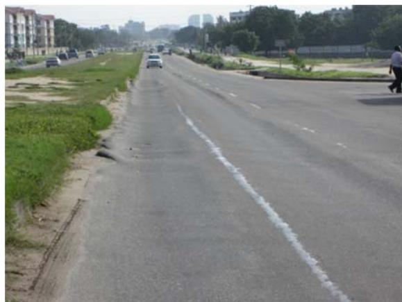
写真 2-1. 供用後の早い段階での舗装の破損
