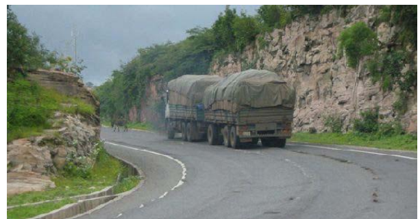
写真1 縦断勾配は7%程度であるが曲線半径の小さな区間、速度は10km/h 以下である(エチオピア)。
