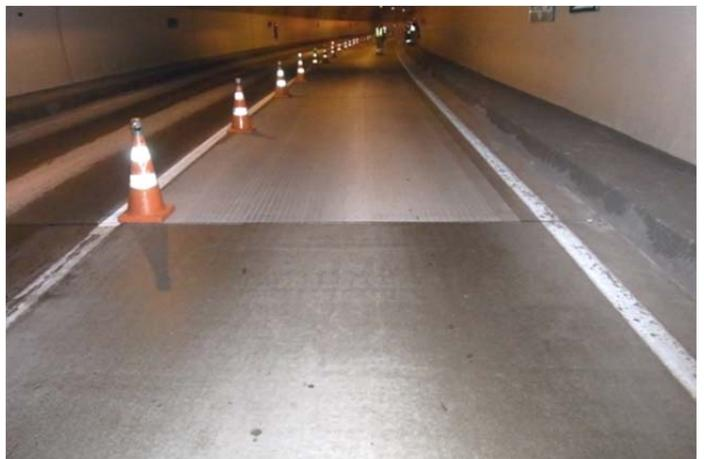
写真-5 奥: DG工法施工後(視認性が良い), 手前: 既設路面
