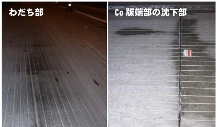
写真-4 路面の削り残り箇所
